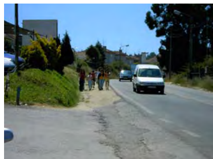
Ausência de passeio, Santarém
