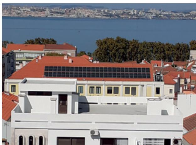
Este edifício apresenta o perfil de consumo adequado com o perfil de produção solar, ou seja, o consumo elétrico deste estabelecimento tem o seu pico entre as 12h e as 14h, uma vez que é quando mais energia é requerida na cozinha (máquinas, climatização, etc.), sendo que este horário coincide com o período em que o Sol está mais intenso e permite produzir mais energia.
