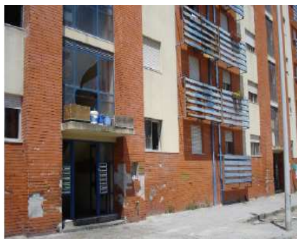
Figura 3 - Edifício no bairro Quinta da Mina
